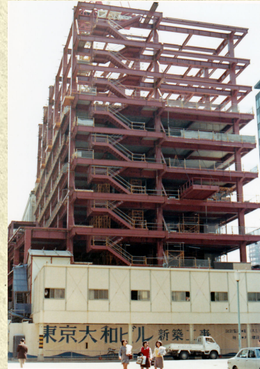
大和銀行東京支店新築工事
